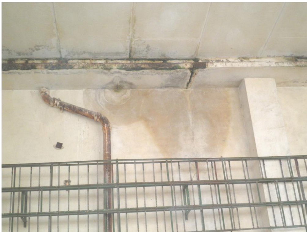
Detail stropu - zatékání v hale
