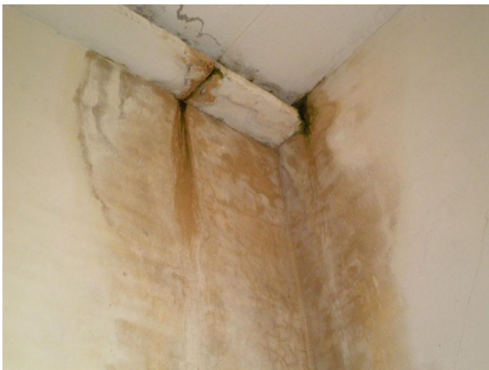
Detail stropu - zatékání v hale
